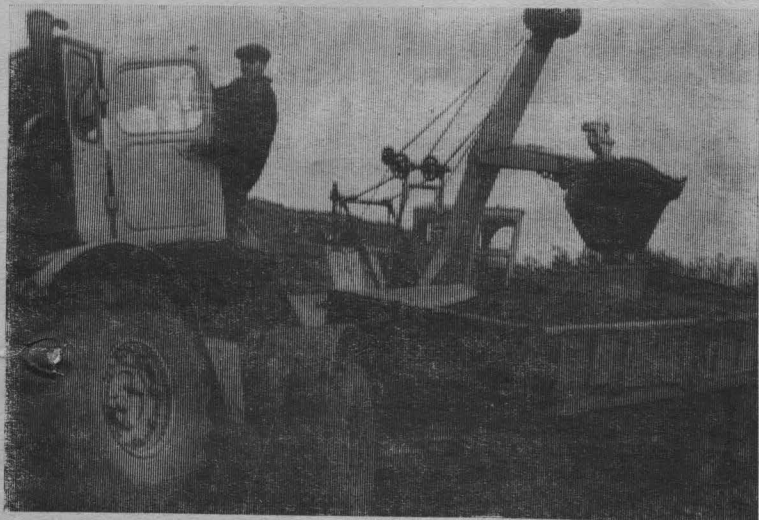
Мощная машина марки К-700. Не проходит и десяти минут, как десятки тонн грунта направляются на объект дороги.
