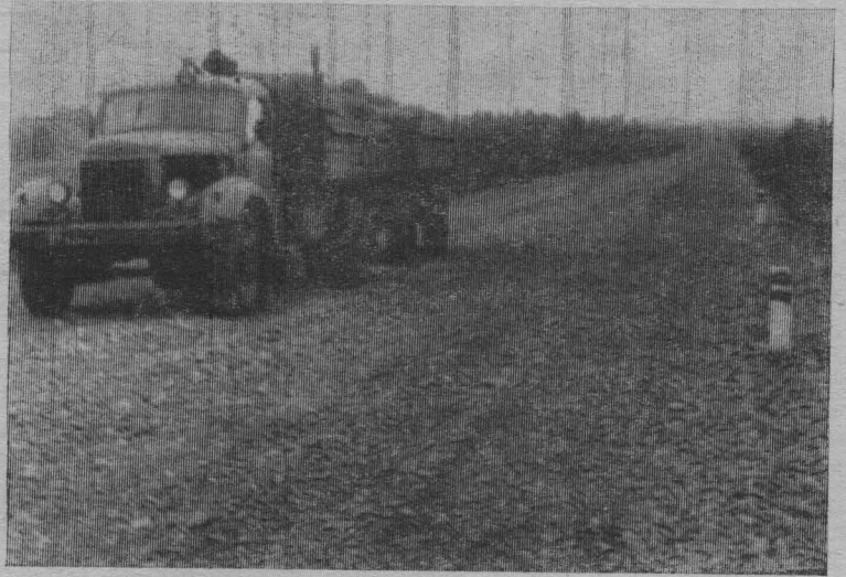
Новая автомагистраль Верх-Чебула—Чумай.
