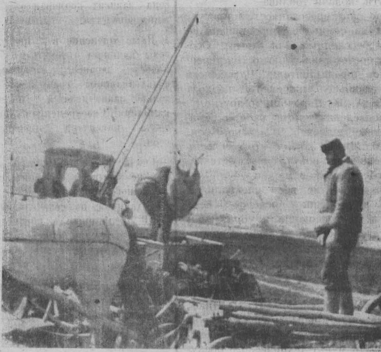
**НА СНИМКАХ:** вот так загружают картофелесажалки шестаковцы — быстро и без большого напряжения сеяльщика. Гидроподъемники есть на всех МТЗ, а вот такого приспособления, кроме шестаковских механизаторов никто не додумается установить;
