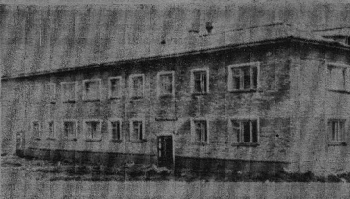
В райцентре 32 семьи отпраздновали новоселье. На днях строители сдали два дома с благоустроенными квартирами. ФОТО Ю. АНЦЕСА.
