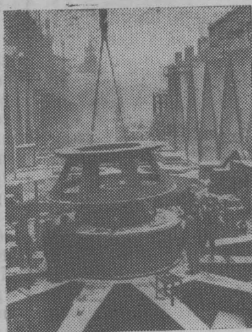
Полным ходом идет сооружение здания Братской ГЭС. Монтажные бригады специализированного участка специализированного монтажа собрали и подготовили к пуску два агрегата мощностью 225 тысяч киловатт-часов каждый. На снимке: бригада специализированного монтажа Владимира Сохатыря, Константина Яблочкина и Михаила Ждановича ведут сборку агрегатов Братской ГЭС.
