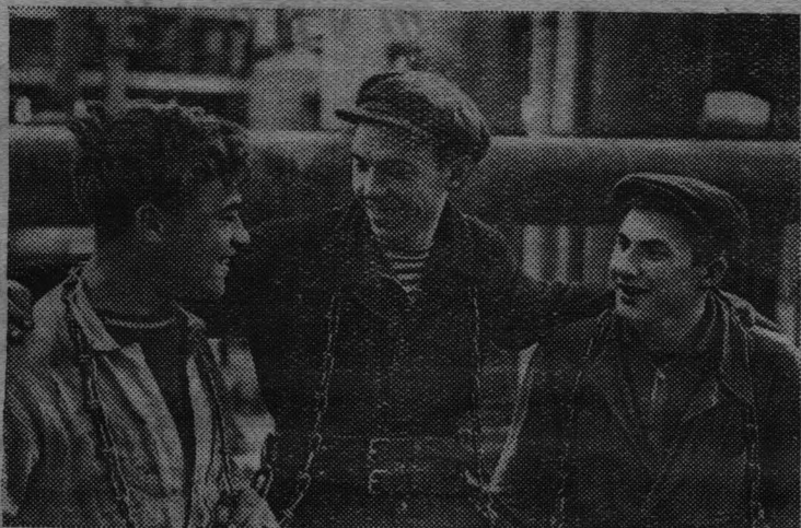
Саратовская область. Сооружение Балаховского сахарного завода вступило в предпусковой период. Строители решили к середине июля нынешнего года закончить монтаж оборудования и стальных конструкций. Тем самым уже в этом году будет обеспечена переработка сахарной свеклы нового урожая.
