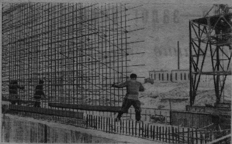
На строительстве Воронежской атомной электростанции закончен монтаж каркаса машинного зала, забетонирован фундамент турбогенератора № 1, подходит к концу монтаж сборных секций сбросного канала, завершены все работы по прокладке циркуляционного трубопровода. В помещении реакторного отделения уложено около 25 тысяч кубических метров бетона.
