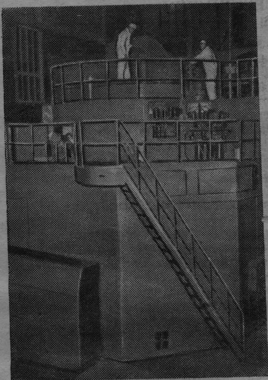
Ленинград. Новый атомный реактор, построенный в Физико-техническом институте Академии наук СССР. Этот исследовательский водо-водяной реактор имеет номинальную мощность 10 тысяч киловатт с интенсивностью потока нейтронов 10 в четырнадцатой степени на квадратный сантиметр в секунду.
