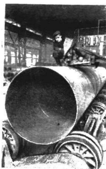
Брянск. Коллектив завода „Строммашина“ изготавливает по заказу Китайской Народной Республики 4 комплекта цементных печей. Производительность каждого комплекта—100 тысяч тонн цемента в год.
