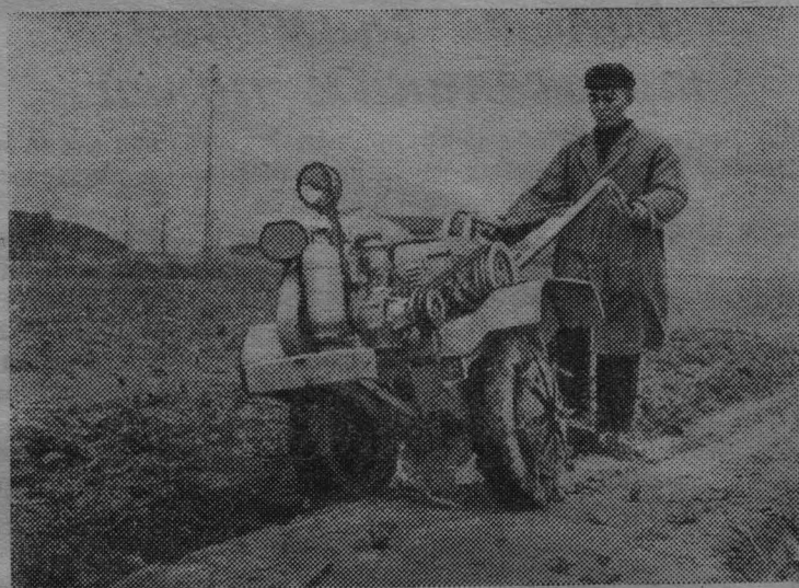
Китайская Народная Республика. В этом году шанхайские заводы намерены выпустить около 800 небольших универсальных тракторов. Первый трактор был изготовлен на заводе Хунсин («Красная звезда»). На тракторе установлен двигатель мощностью 4 лошадиные силы.
