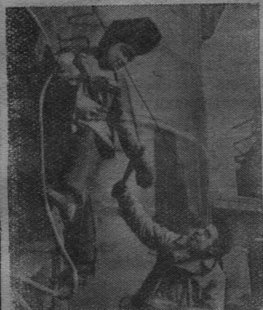
Днепропетровская область. Ни днем, ни ночью не прекращаются работы на сооружении домной печи № 4 завода «Криворожсталь». Строители «Криворожской-комсомольской» домны опережают график работ.
