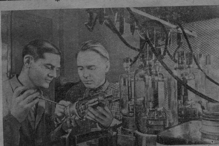
На Куйбышевском четвертом подшипниковом заводе молодыми изобретателями В. А. Исаевым и Ю. И. Сахаровым разработана конструкция и изготовлен ультразвуковой генератор мощностью в 6,5 киловатта. Он предназначен для промывки в специальной установке приборных подшипников. Внедрение ультразвуковой промывки значительно повышает качество собранных подшипников. Производительность установки обеспечивает промывку всех подшипников приборного цеха.
