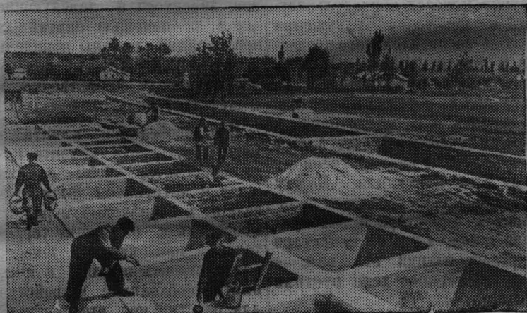
Крымская область. Колхоз имени Сталина Симферопольского района заканчивает строительство силосных сооружений. На снимке: бригада Н. Я. Морозова цементирует силосные ямы, предназначенные для силосования початков кукурузы.
