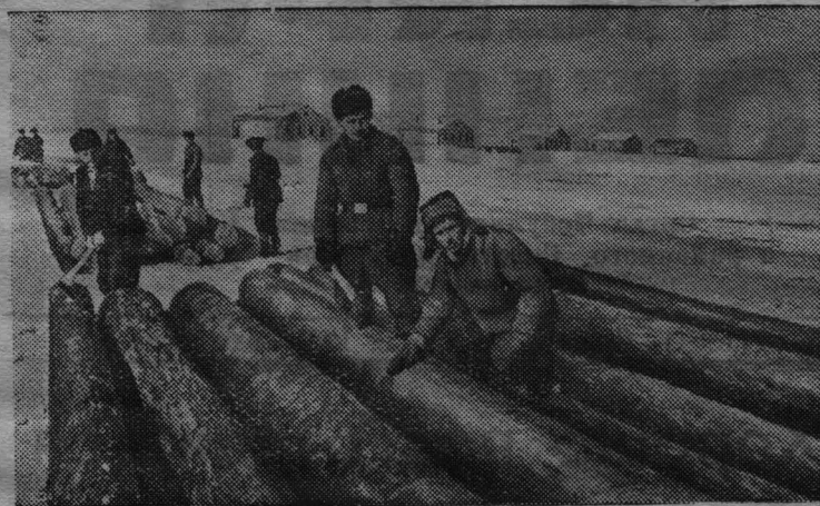
Амурская область. Большое строительство развернулось в новом совхозе «Чесноковский», созданном для освоения целинных и залежных земель.
