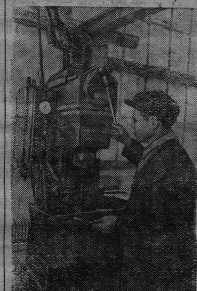
**Новосибирская область.** Барышевская машино-тракторная станция первая в области организовала ремонт тракторов по поточному-узловому методу. Этот метод требует от ремонтников высокой четкости. Тщательно продумана технологическая карта, составлен ежесуточный график выпуска не только машин, но и отдельных узлов и деталей.
