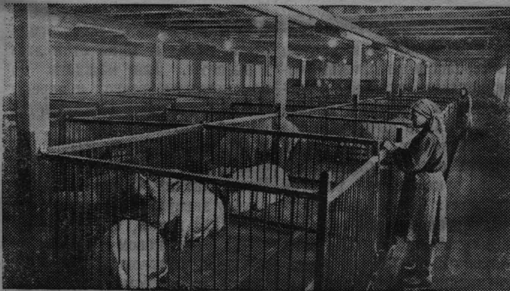
Новосибирская область. В колхозе „Новая жизнь“ Новосибирского района хорошо развито общественное животноводство. С помощью шефа — коллектива Новосибирского завода „Сибсельмаш“ — сооружается скотный двор на 248 голов с доильным залом; построен большой свинарник.
