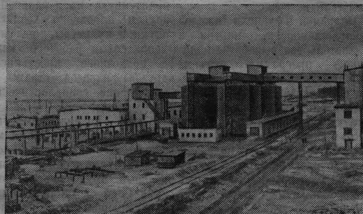
Молотов. На окраине города завершается строительство крупного завода железобетонных изделий для новостроек Западного Урала. Его цехи оснащаются новейшим оборудованием—мощными бетономешалками, транспортерами, электрокранами, сушильными камерами. Механизация позволяет выпускать продукцию поточным методом. Завод будет давать 15 тысяч кубических метров железобетонных изделий, из них пять тысяч кубометров—на polygonальных площадках.
