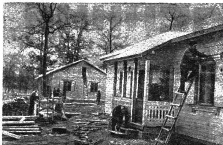
Волынская область. В Киверцовской МТС выстроены типовые мастерские, здание конторы и десять домов для механизаторов. На снимке: строительство домов в Киверцовской МТС.
