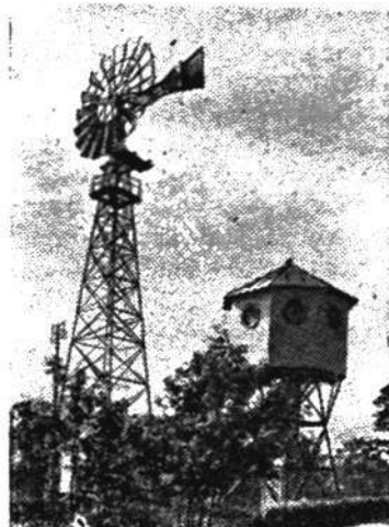
Ветронасосная станция с ветродвигателем «ТВ-8».
