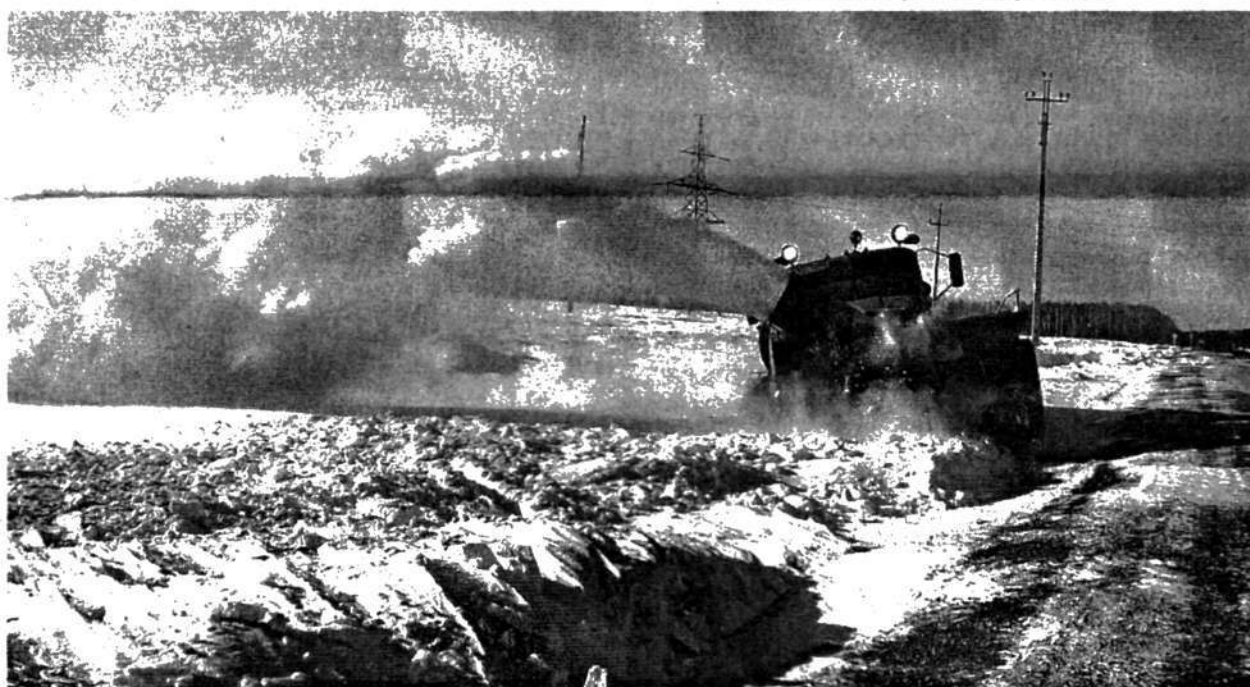
Идет очистка дорожного полотна.
