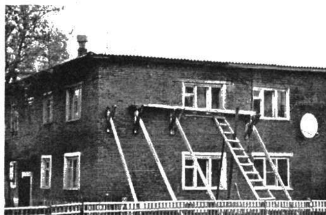
Ремонт жилого дома.
