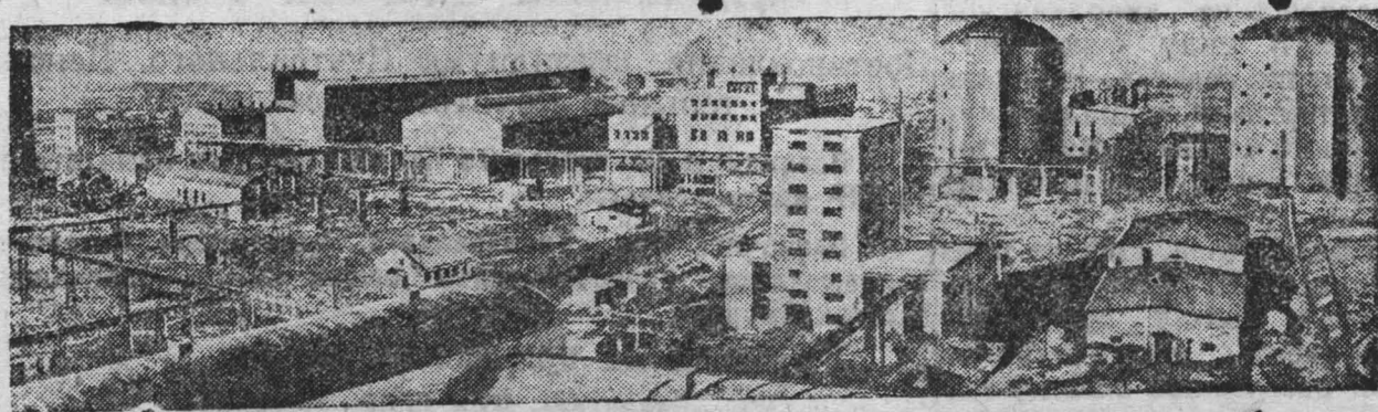
НА СНИМКЕ—общий вид Бобриковского химкомбината.
