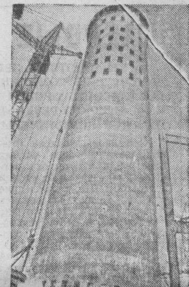
В Новгородском производственном объединении «Азот» закончено сооружение башни грануляции. Ее высота — 117 метров, диаметр составляет 28 метров. Башня возводилась методом скользящей опалубки.
