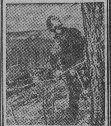
Тайга отступает. Геннадий Комиссаров, строитель из Башкирии, прокладывает просеку под полотно будущей железной дороги. (Фотохроника ТАСС).
