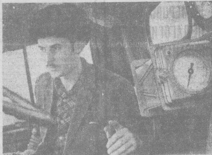
Александр Фролов производит наладочные испытания тензометрической системы в автомобиле. Фото И. Павленко. Справа от него шкала прибора, указывающая точный вес груза, находящегося в кузове автомашины. Фотохроника ТАСС
