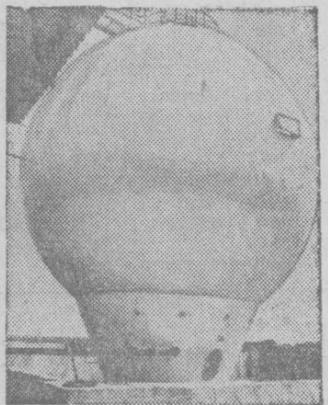
Первый в ГДР шарообразный резервуар емкостью в 300 тонн для хранения азотных удобрений введен в эксплуатацию в агрохимическом центре Ванцлебен.
