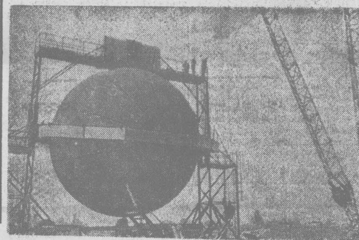
Огромный стальной шар диаметром в 10,5 метра монтируется на плодородной Магдебургской равнине, славящейся в ГДР высокими урожаями. Такие резервуары, предназначенные для хранения аммиачной воды, будут установлены в скором времени и в других местностях республики. Жидкие химические удобрения получают в сельском хозяйстве все более широкое применение.
