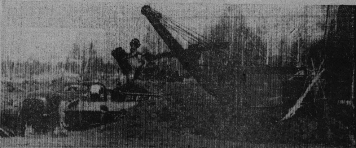
На снимке: первые кубы выемки грунта на строительстве линии Артышта — Подобас, 1962 год.
