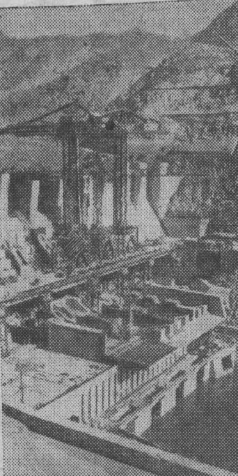
В Наглу при техническом содействии Советского Союза соружается крупнейшая в Афганистане гидроэлектростанция мощностью 90 тысяч киловатт. Сейчас идет монтаж третьей турбины. Первый и второй агрегаты уже подключены в энергетическую сеть и дают ток Кабулу и Гульбахарскому текстильному комбинату. К лету 1967 года будет полностью завершено строительство ГЭС.
