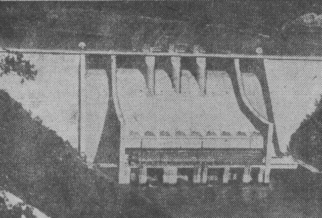
**НАРОДНАЯ РЕСПУБЛИКА БОЛГАРИЯ.** Плотина гидроэлектростанции Ивайловград, сооруженная в Родопских горах на реке Арда. Ее длина 250 метров, высота — 70 метров. Созданное здесь водохранилище объемом свыше 180 миллионов кубометров воды позволяет орошать не только большие площади плодородных родопских полей, но и 30 тысяч гектаров земельных угодий в Греции.
