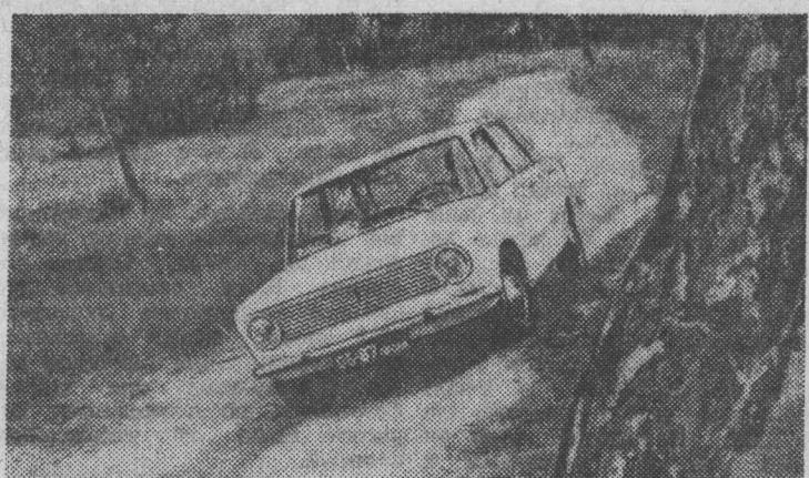
В Московской области проходят испытания малолитражного автомобиля «Фиат-124» — модели, которую предполагается выпускать в количестве 500 000—600 000 штук в год. Промышленный комплекс по производству этого автомобиля СССР закупает у фирмы «Фиат» (Италия). «Фиат-124» — малолитражный четырехместный седан с четырехцилиндровым мотором водяного охлаждения мощностью 62 л. с., с максимальной скоростью 100—130 км в час. У него дисковые тормоза, пружинные рессоры, объемный багажник.
