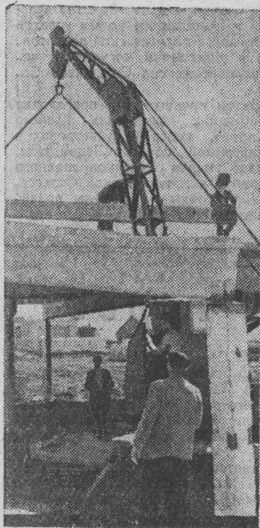
В хозяйствах Красноярского края ведется большое строительство производственных помещений. На снимке: сборка коровника в Черноярском совхозе. Фотохроника ТАСС.
