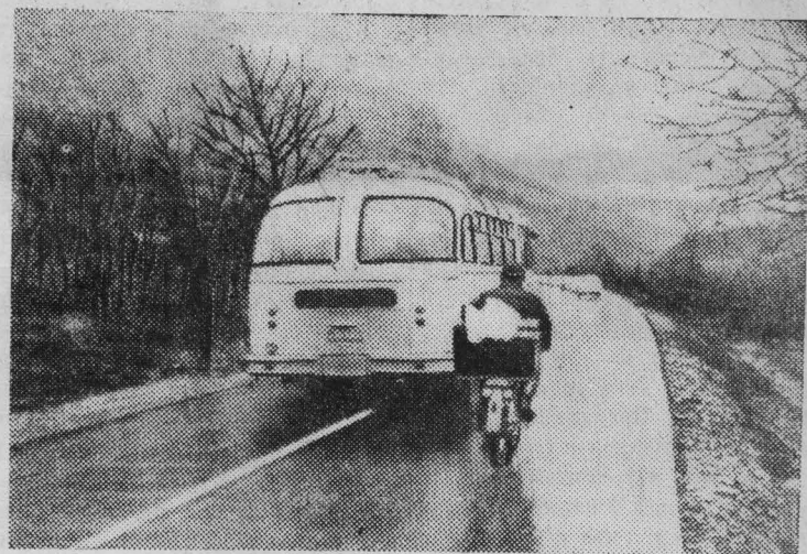
Закончилось строительство автомобильной дороги на участке от югославского города Ниш до границы с Болгарией. Белград и София связаны теперь первоклассной магистралью. Эта автодорога имеет для Югославии и Болгарии большое экономическое значение. НА СНИМКЕ: часть новой дороги Ниш — Димитровград. Фото ТАЮГ — ТАСС.
