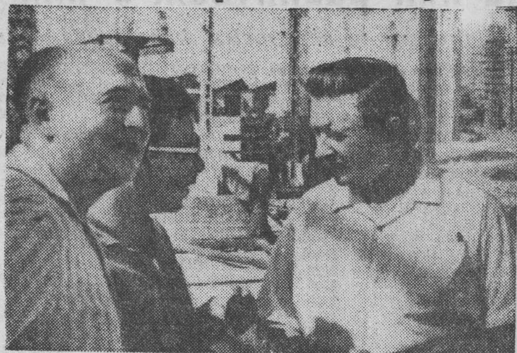
В Алеппо (Сирийская Арабская Республика) с помощью Советского Союза и Венгерской Народной Республики сооружается завод по производству железобетонных шпал. На снимке (слева направо): венгерский инженер Папп Делла, сирийский инженер Саид Фарук и советский инженер Василий Крыжановский на строительстве.
