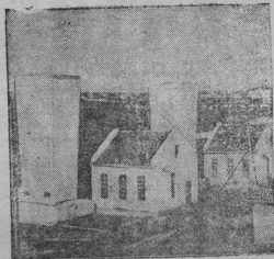
Вентиляторы мощностью в 900 кубометров воздуха в минуту.
