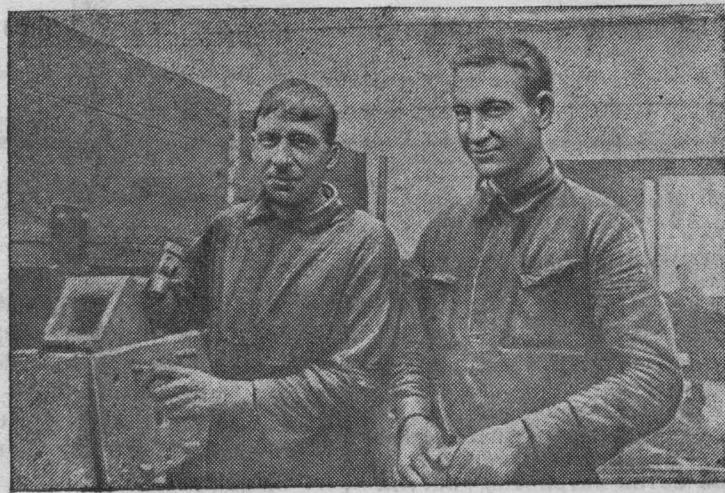
Двухсотники Новокузнецкого вагонного участка, систематически перевыполняющие сменное задание, высококачественно ремонтирующие вагоны.
