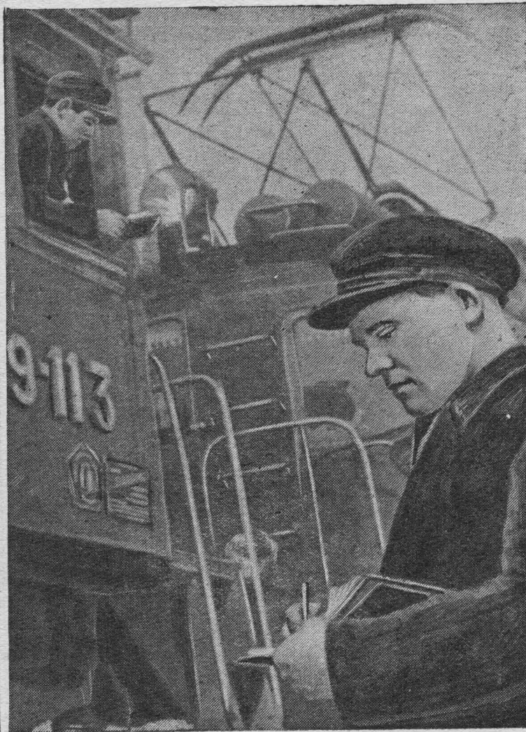
СЕМЕНОВ — осмотрщик-автоматчик ст. Усаты. Стахановец. Отправляет поезда без утечки воздуха из тормозной магистрали. На снимке: т. Семенов выдает гарантийную путевку машинисту электровоза.
