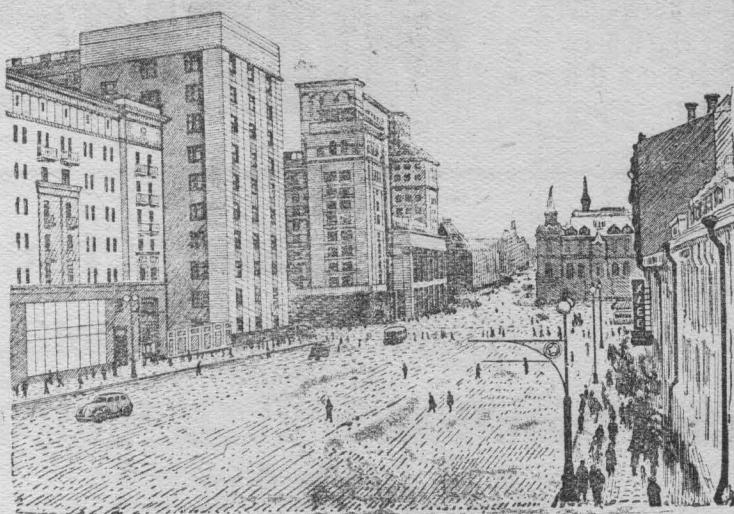
На снимке: улица Горького после реконструкции. (Прессклише).
