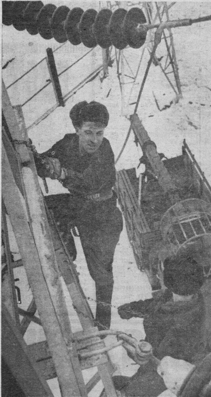
Идет монтаж линии электропередач. Скоро по проводам заструится живительный ток, столь необходимый капролактаму.
