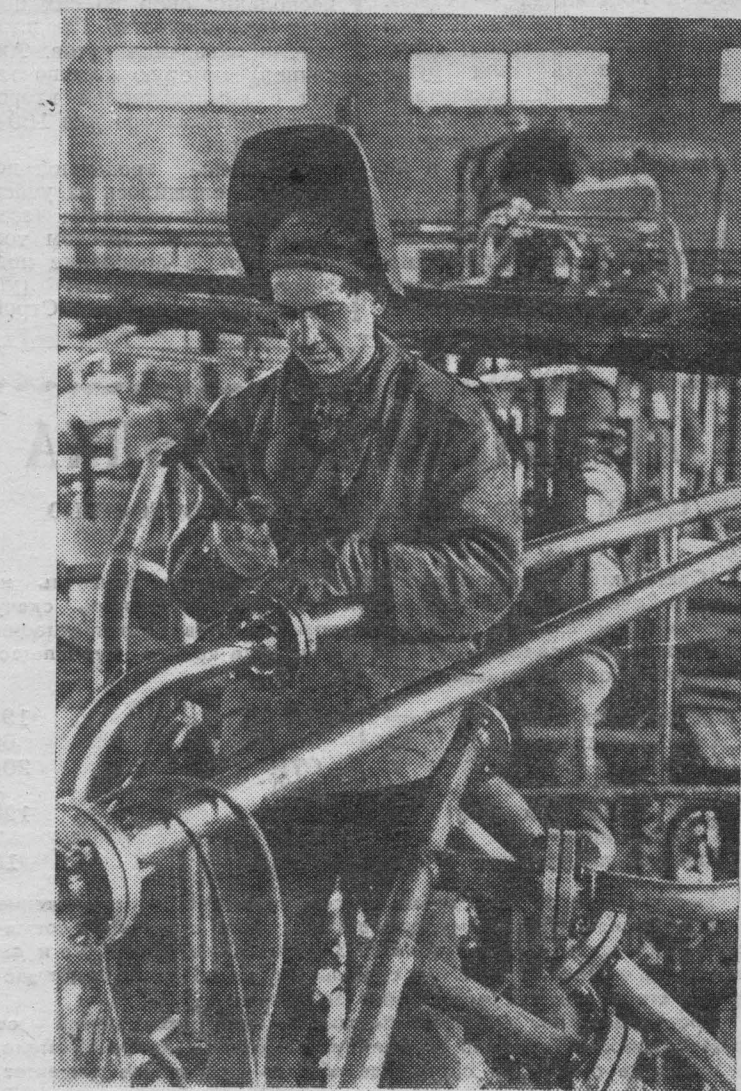
Данил ШИРЕНИН из бригады монтажников Владимира Филимонова ведет врезку фланцев аргоно-дуговым методом в корпусе № 955.
