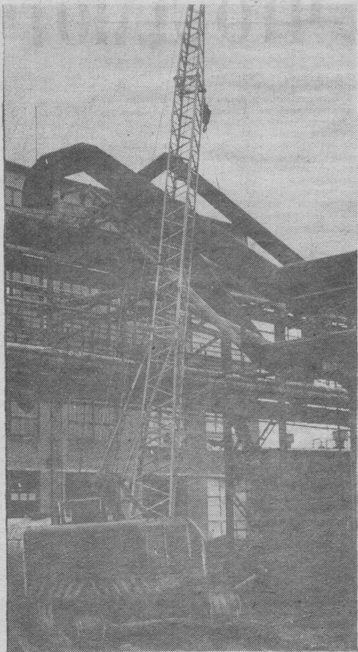
Совсем недавно так выглядела площадка около 958 корпуса второй очереди капролактама. А сегодня здесь заканчивается отделка и подготовка к пуско-наладочным работам. Недалек день, когда из этого корпуса будут отправлены народному хозяйству страны первые тонны лактама.
