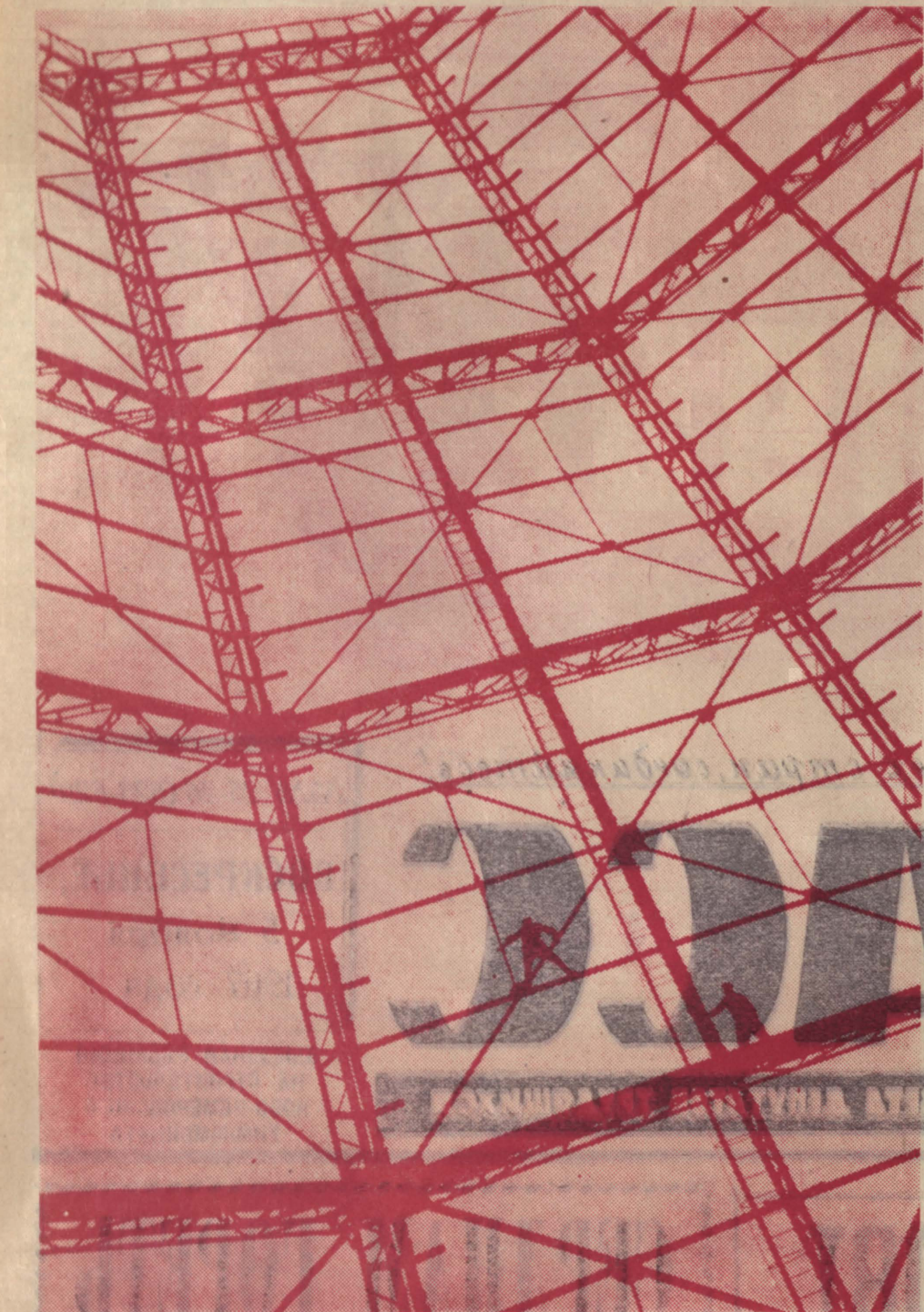
Перед началом штурма на графине 15 водооборотного цикла. Фото В. Кафо.
