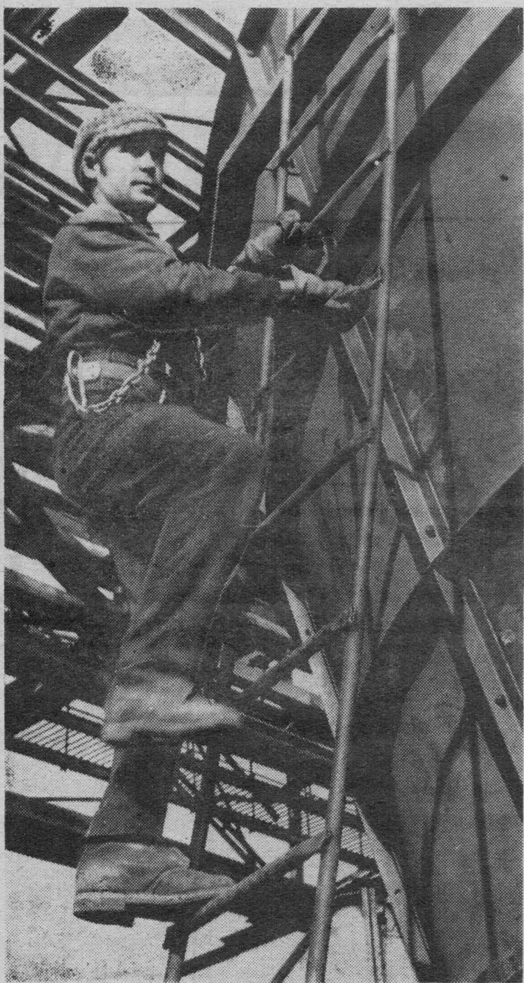
Бригада Георгия Демина из КМУ-1 ведет монтаж вентиляторов градирни 6 водооборотного цикла. НА СНИМКЕ: член бригады, коммунист Виктор Рыкин. Фото В. Добрынина.
