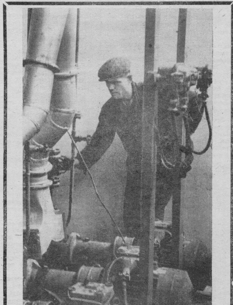
В 954 корпусе началась обкатка оборудования. Недалек тот день, когда реакторный блок комплекса Капролактама-2 будет поставлен на линейку готовности.
