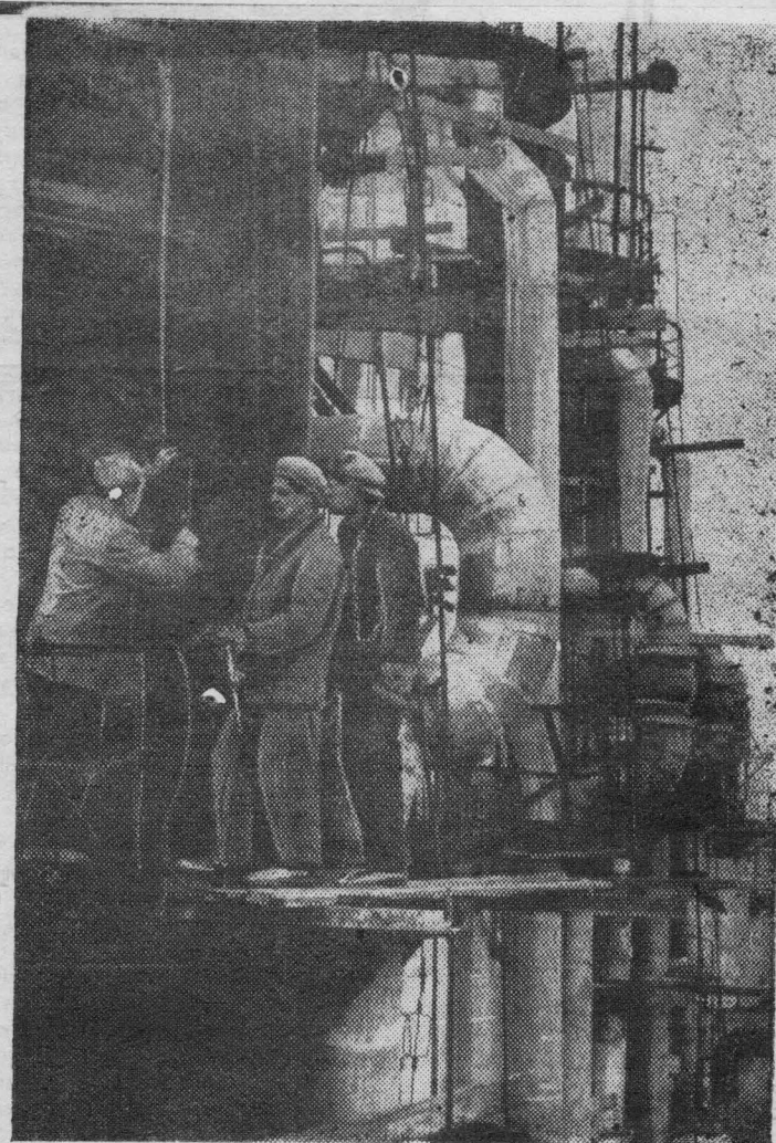
Хорошо потрудился на монтаже и опрессовке трубопроводов 984-го корпуса прославленный коллектив бригады И. Сероштанова из КМУ-1. НА СНИМКЕ: монтажники за работой.
