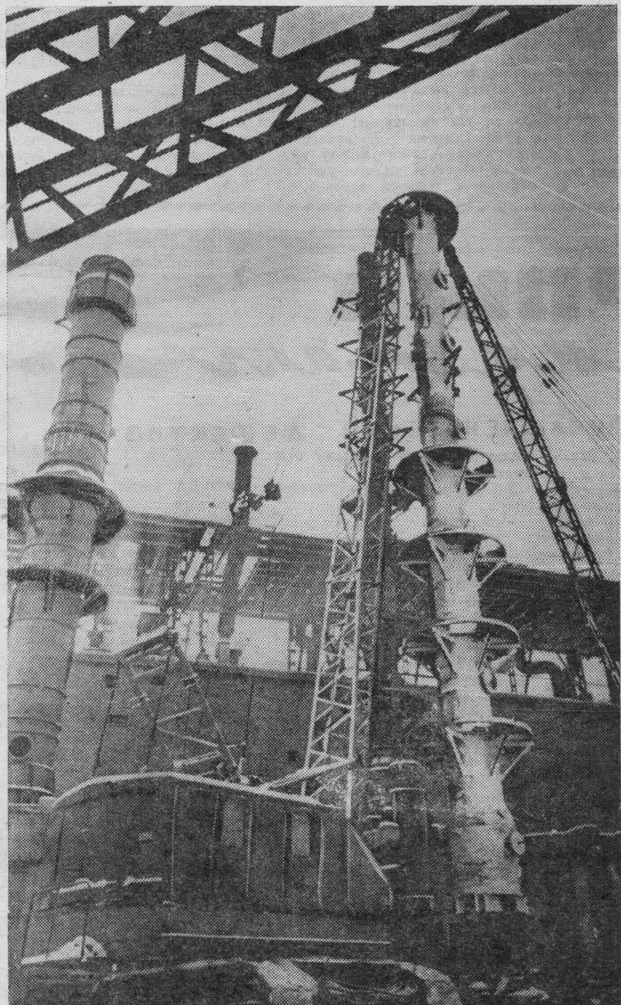
НА КАПРОЛАКТАМЕ-2 продолжается монтаж оборудования. Бригада кавалера ордена Ленина Ивана Федосеева установку колонн гидрирования на этажерки 956 корпуса производит укрупненными узлами вместе с ходовыми площадками.
