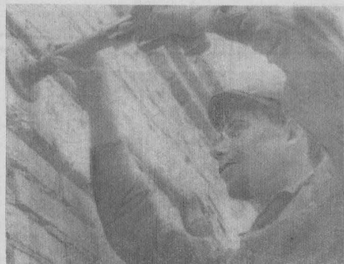
**БЫСТРЕЛ!** И металлическая пластина плотно прилегает к бетону. Электромонтажники крепят к пластинам трубы для электропроводки, кронштейны.
