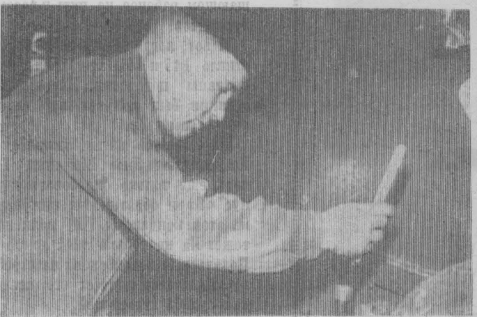
Мастер КИП Василий Золотницкий устанавливает на турбине термометр для замера температуры масла.
