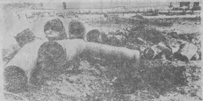
С каким трудом пришлось бригаде т. Вылегжанина заменять трубы ГЗУ от приямка, кто знает? Они откопали 30 метров траншей, вырезали и выбросили тонны металла. На снимке: часть труб ГЗУ, превращенных в металлолом.
