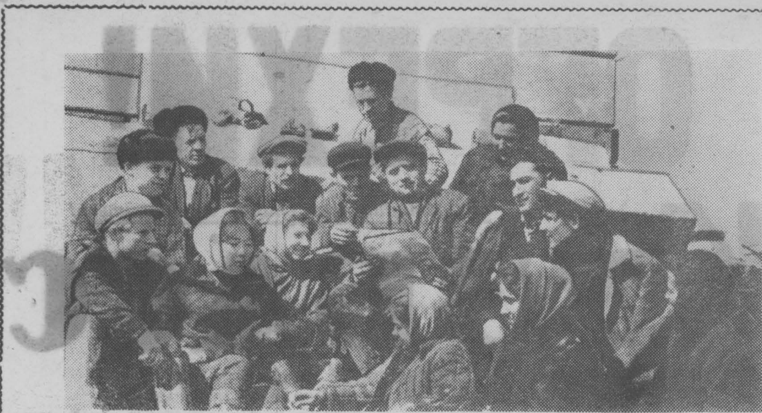
Дружно живут и трудятся кровельщики-изоляционщики из бригады Станислава Забелы. Недавно они закончили изолировку защитным слоем галерей № 1 и сделали кровлю багерной.
