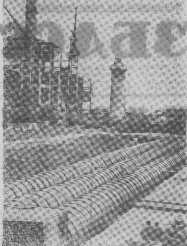
Стройка. Вид на 7 блок и циркводоход.
