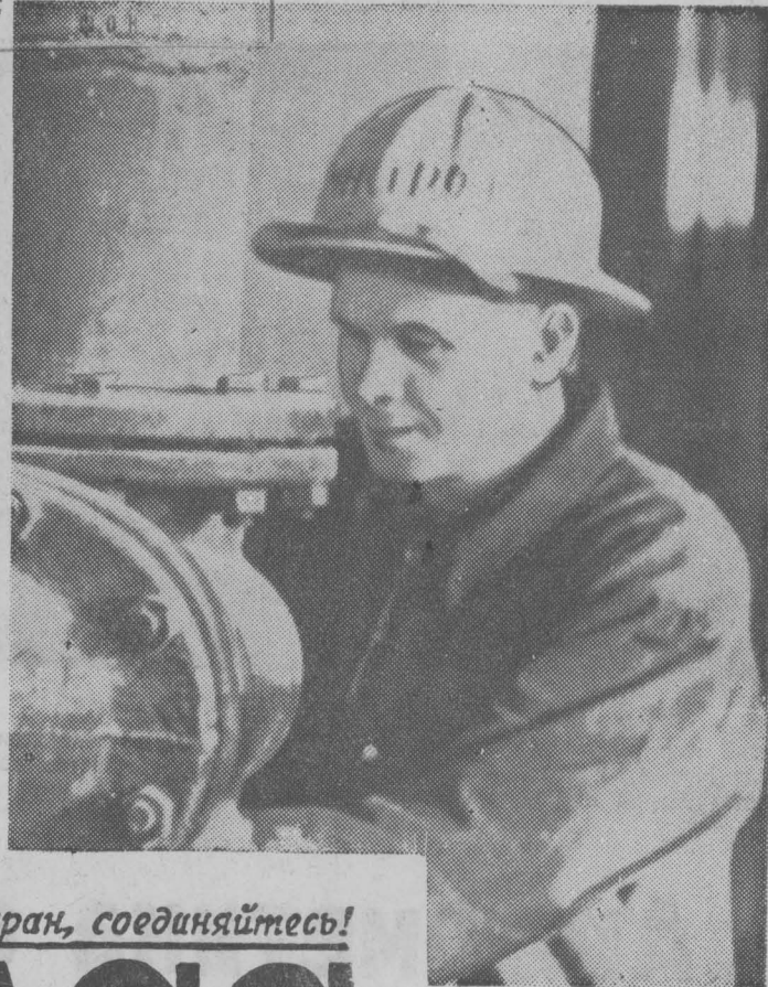
Хорошо трудятся трубопроводчики бригады Филимонова. Анатолий Дорошенко ведет монтаж трубопроводов спутников в 983 корпусе. Фото В. Фомченко.
